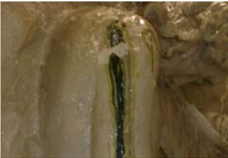
Particolare: caduta delle prime scaglie di gel con rimozione di parte della colatura
