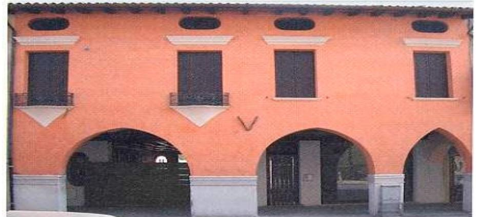
*fig.15. Portogruaro, via Martiri 72-74. Intonaco con alterazione dei valori storici del fronte*
